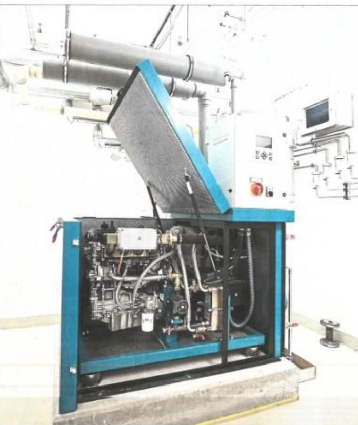
Was ist ein Blockheizkraftwerk? Dies mit frigus betriebene Cottendorf tritt einen Generator an, der Strom erzeugt.
